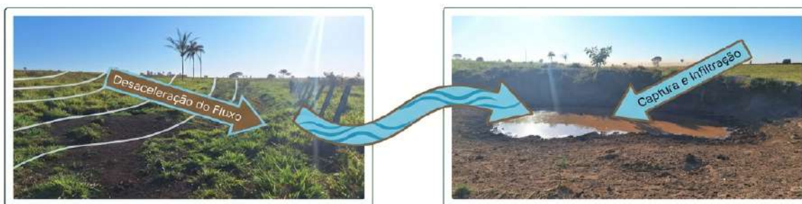
Fig. 01 - Terraceamento e construção de barraginhas para contenção do fluxo erosivo, como infraestrutura verde na proteção das nascentes.
