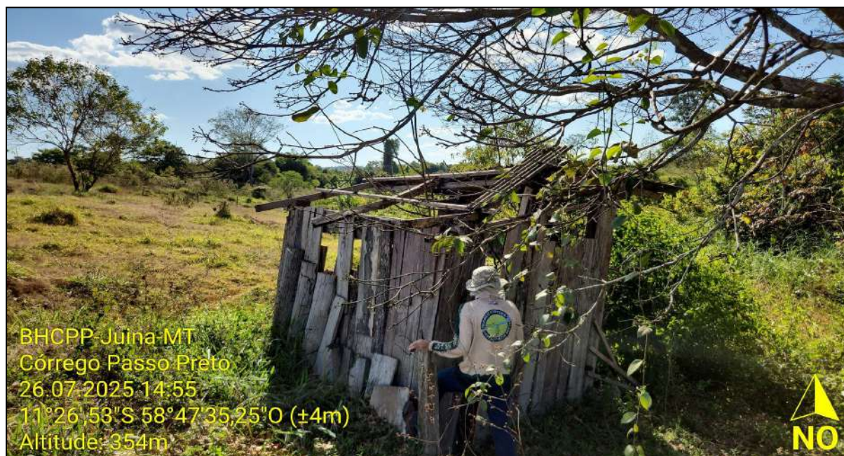
Fig. 51 - Antiga cobertura de cacimba localizada sobre a nascente.
