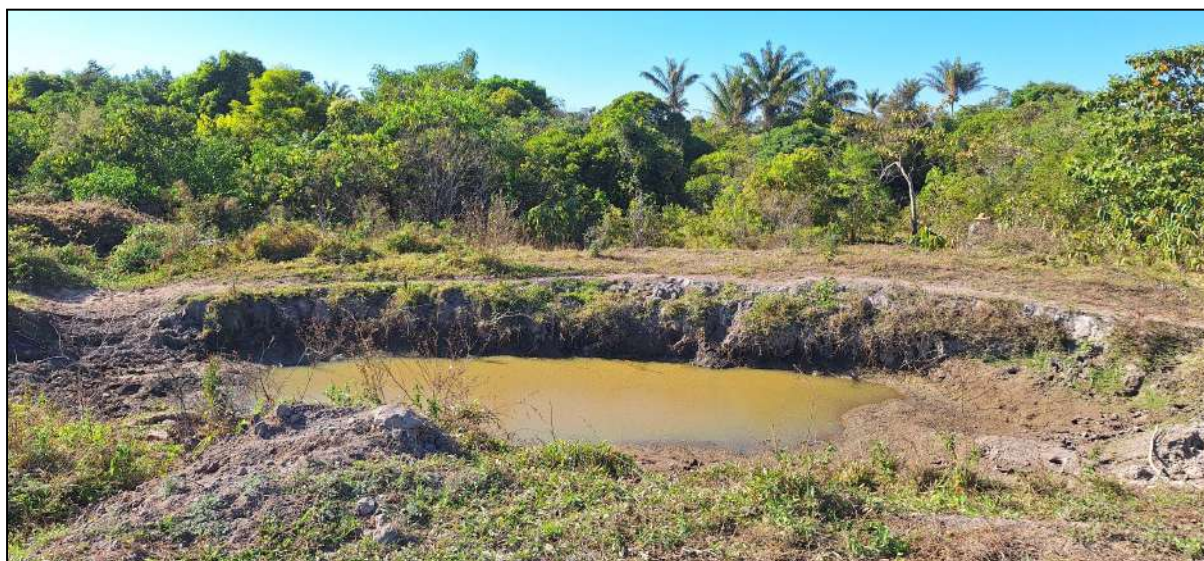
Fig. 23 - Barraginha acima da nascente 3B. Conjugadas com terraços de base larga, construídos em curvas de nível, essas estruturas captam e infiltram água no solo de forma eficiente na sub-bacia do Passo Preto.
