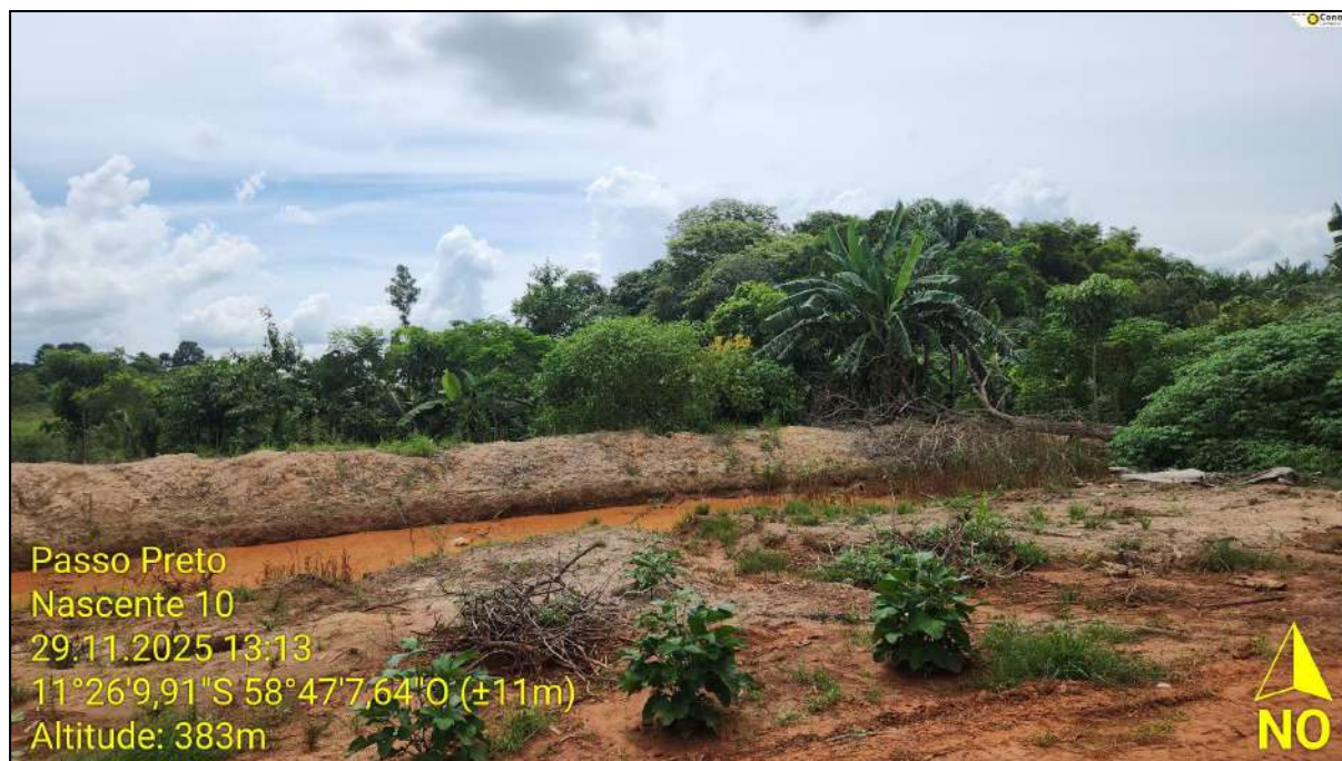
Fig. 55 - Duas barraginhas circundam e protegem a nascente 10 para evitar o assoreamento e ao infiltrar a água que seria perdida em forma de escoamento superficial no lençol freático.
