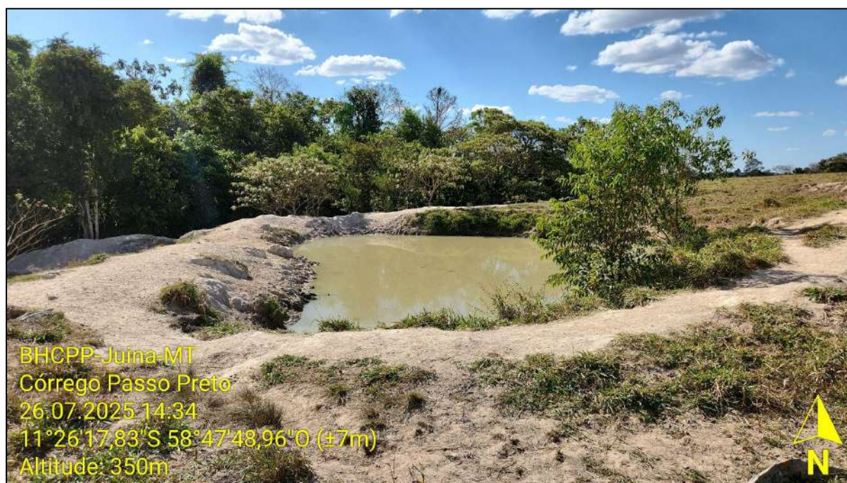
Fig. 41 - Barraginha instalada a montante da Nascente 07A, destinada à contenção do escoamento superficial, redução da erosão e aumento da infiltração de água no solo.
