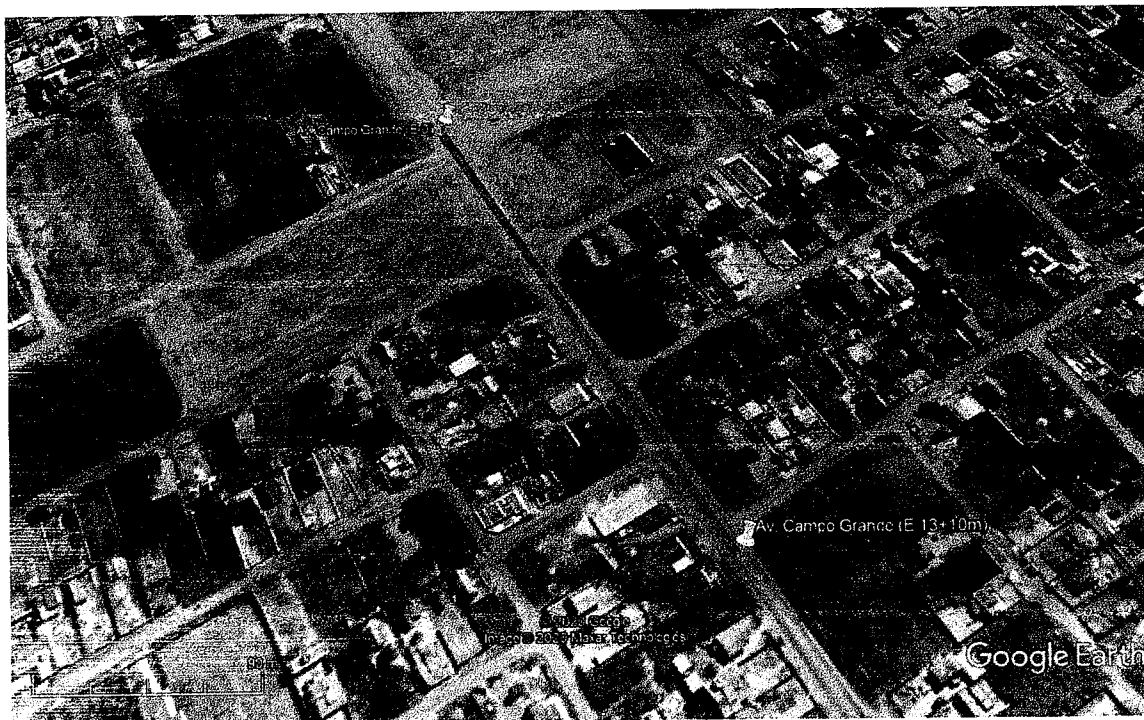
Foto 1 – Avenida Campo Grande (1ª Etapa) Fonte: Kley Willian
