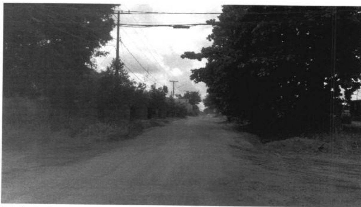
Foto 2 – Av. Gov. Fernando Correa da Costa (Via Principal de Acesso ao IFMT – Campus Juína) (Início do Trecho – Cruzamento com Rua Guerino da Luz)
