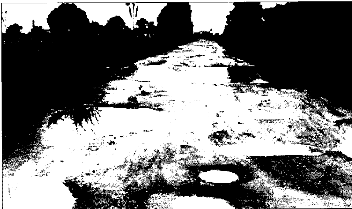
Foto 3 – Estrada de Acesso ao IFMT – Campus Juína (Situação precária de trafegabilidade em períodos chuvosos)
